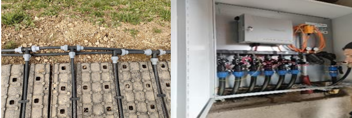
Mise en œuvre du système Hydroground
