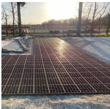
Stabilisation du sol
