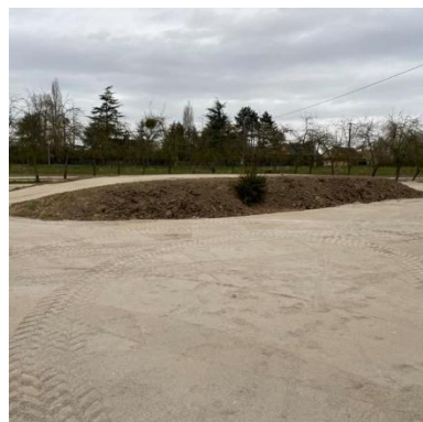
Préparation du terrain
