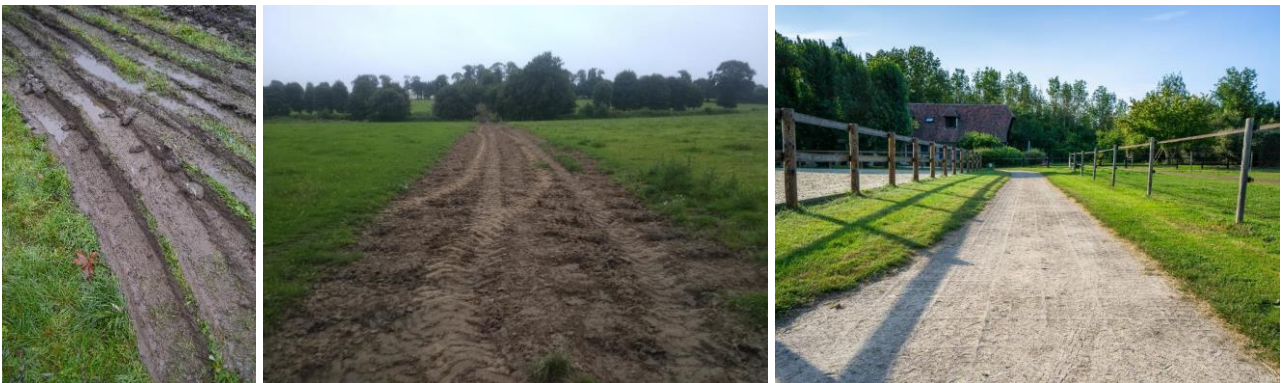
Stabilisation d'un chemin (avant/après)
