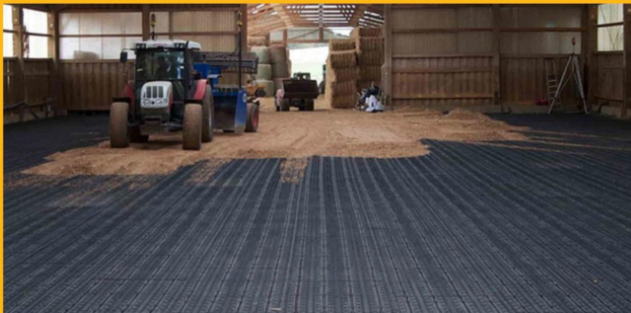
L'irrigation HYDROGROUND est composée d'un tapis en PVC recyclé où sont insérés des tuyaux de goutte à goutte et posé sous la couche de travail. Il permet l'arrosage des sols équestres de travail couverts ou non : carrière, manège, rond de longe et rond d'Havrincourt.
