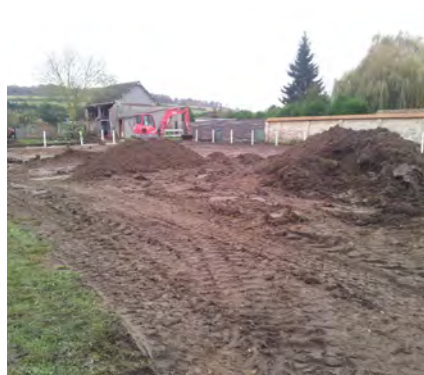
La mise en place des fondations
