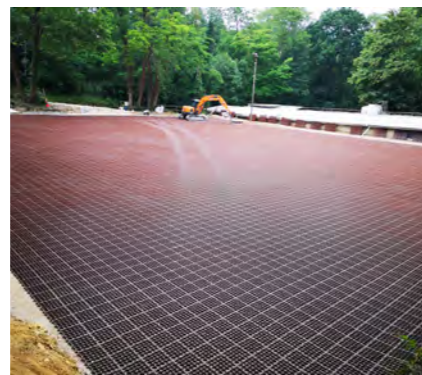
La stabilisation du sol
